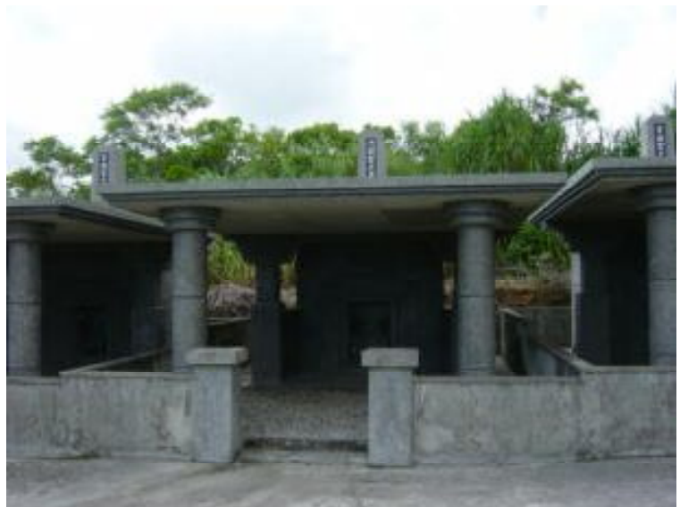
写真8 庇のついた新しいタイプの塔式墓
